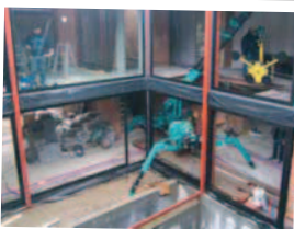
Pose de vitrages
