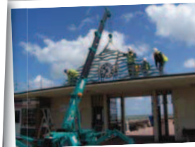
Travaux de levage variés
